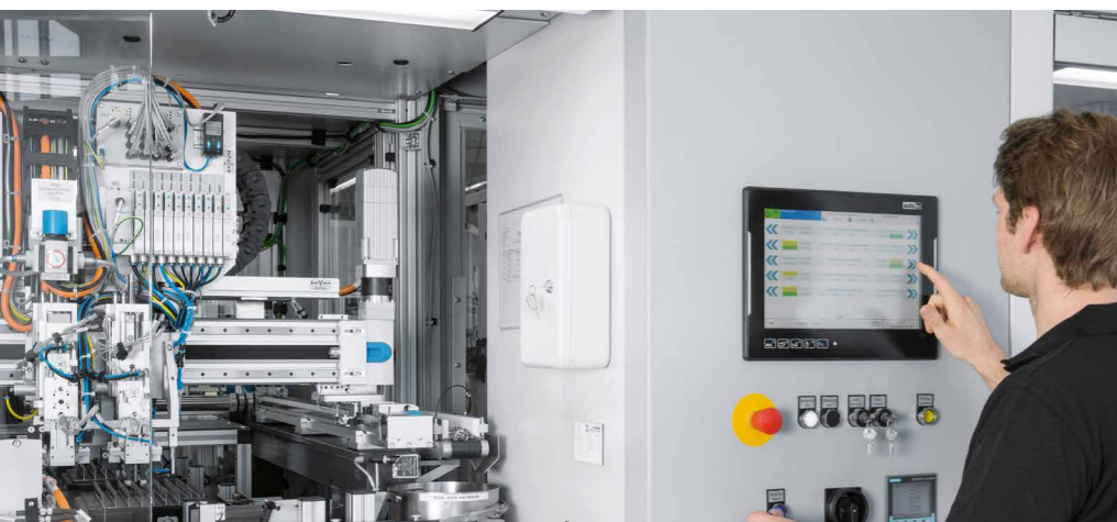
Optimierte Produktion: Montagesteuerung der VUVG-Automatisierung bei Festo
